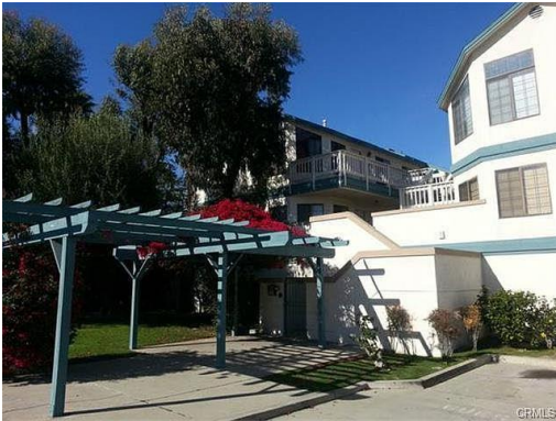
3 Eingang zum Wohnkomplex
