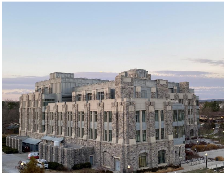
Foto 4: Vorlesungsgebäude Goodwin Hall
